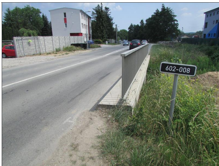
Levá krajnice s římsou a zábradlím
