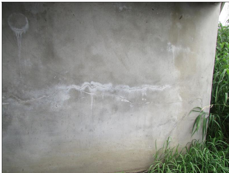
Pohled na opěru OP1 vlevo - vodorovná trhlina s průsaky
