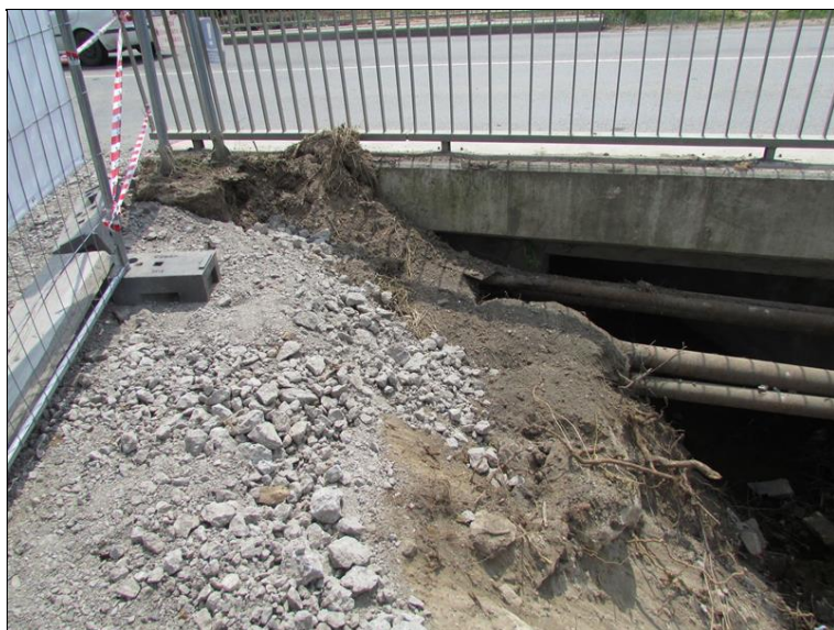
pravá římsa u OP1 zahrnuta zeminou od přilehlé probíhající stavby
