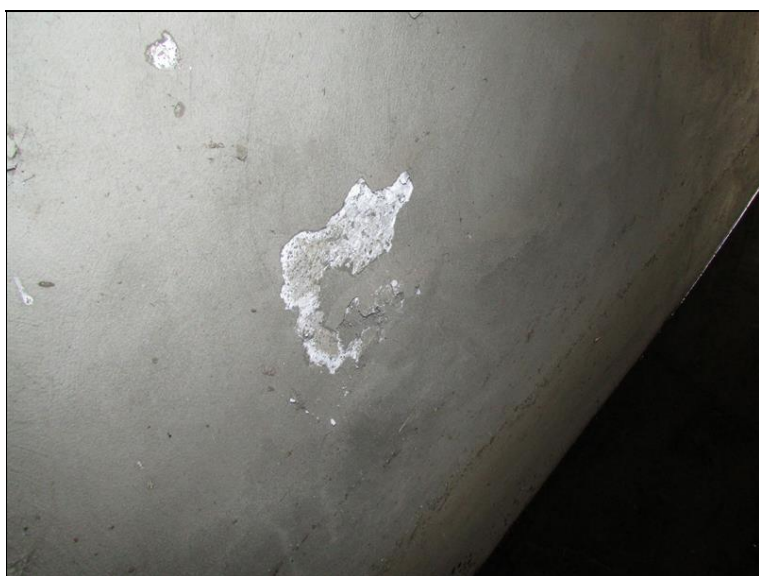
Odlupující se vrstva sanace na OP2
